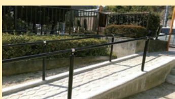
さくら苑まえ公園の段差にスロープが実現。
