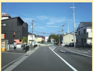
都市計画道路の整備が完了。信号機設置、通学路に横断歩道設置。
