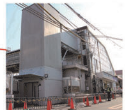
JR千里丘駅西口駅前の整備について「千里丘西地区市街地再開発準備組合」設立。2013年度から整備計画の策定に向け取りくみがはじまっている(摂津市)。JR千里丘駅西口エレベーターは2014年12月完成
