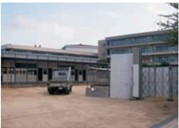
耐震工事がすすむ山一小学校
