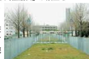
(仮称)西吹田駅前線道路立体交差事業
