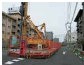
十三高槻線寿町工区
