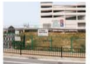
山田駅東側の公益施設予定地 ▲
