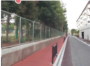
▲南吹田5丁目、南小学校周辺の歩道整備
