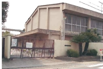
吹田第6小学校体育館の 大規模改修17年竣工
