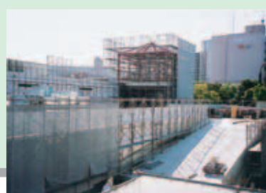
南千里駅商業区域工事
