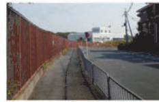
暗くて危険な歩道街灯の設置を要望
