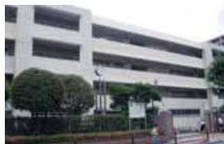
今回の耐震補強工事が行われる豊津第一小(写真)
