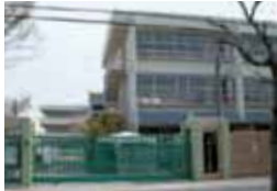
千里たけみ小学校耐震工事 4億7250万円
