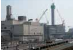
ごみ焼却施設建設の下請け工事 69億1950万円
